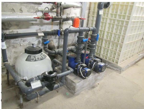
í Obr. 12 – MaR kvality vody, elektrolýza a privátní filtr nevyhovující danému provozu, tepelný výměník
