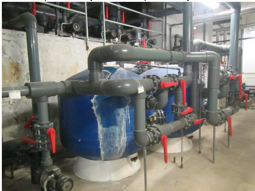
Obr. 10 – pohled na ovládání filtrů rekreačního bazénu. Nad nimi za zábradlím jsou instalovány pohony atrakcí
