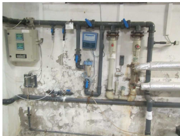
Obr. 11 – úpravna vody dětského bazénu, jímka s venkovní výztuží,
