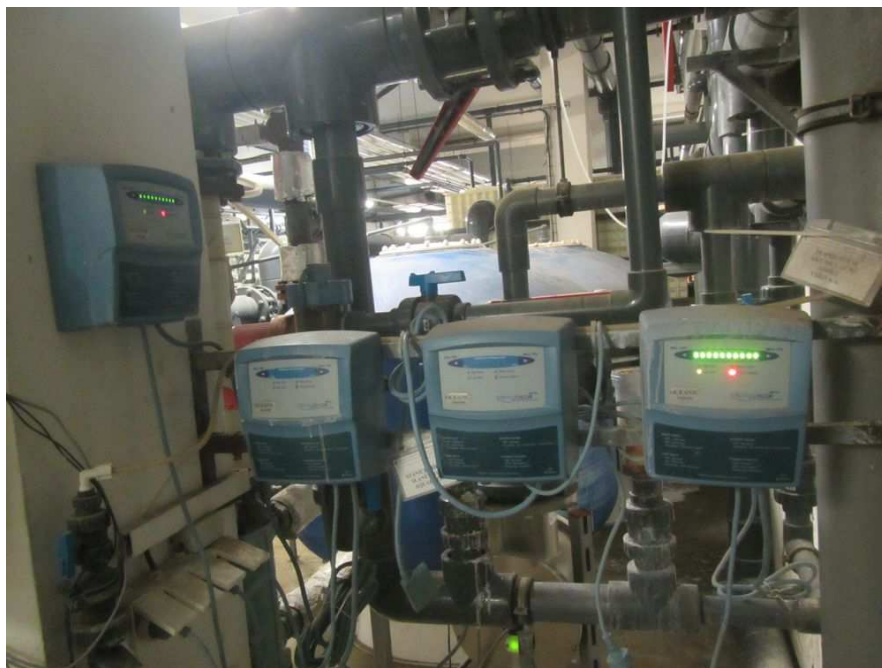
obr. 9 ovládací a signalizační skřínky elektrolýzy – celý s elektrodami jsou instalovány pod skříňkami na potrubí cirkulace – výtlačku filtrované vody
