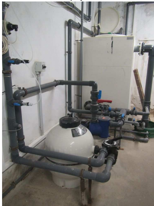
Obr. 16 – Technologie ochlazovacího bazénu – pouze jedno cirkulační čerpadlo bez regulace, filtr pro privátní využití s nízkou mocností filtračního materiálu, plastová akum. jímka zvětší hladká, výztuhy zevnitř
