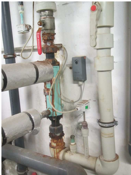
Obr. 15 – Tepelný výměník Bowman s viditelnými známkami koroze na kovových částech včetně spojů, které jsou ve styku se slanou bazénovou vodou.
