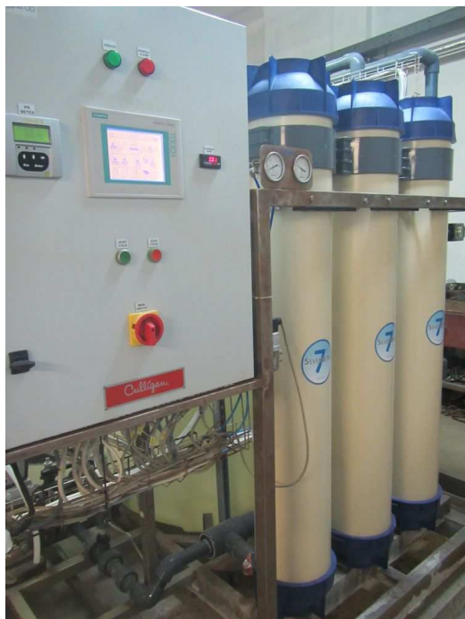
Obr. 18 zařízení ultrafiltrace bazénové vody
