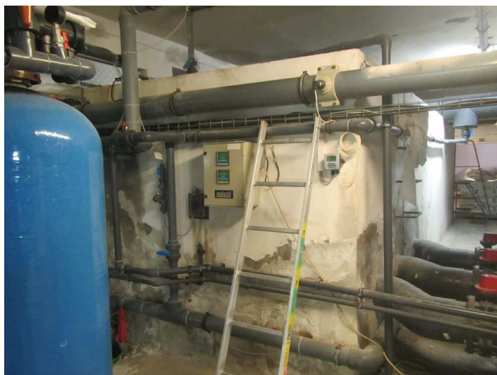
Obr. 3 – pohled na technologii a potrubní rozvody u akumulční jímky plaveckého bazénu. Jejich instalace je provedena tak, že brání průchodu obsluze mezi jímkou a plaveckým bazénem a je nutné celý prostor obcházet nebo se „proplazit“ pod dnem bazénu. Na stěně akumulční jímky je instalováno zařízení hlídající kvalitu bazénové vody
