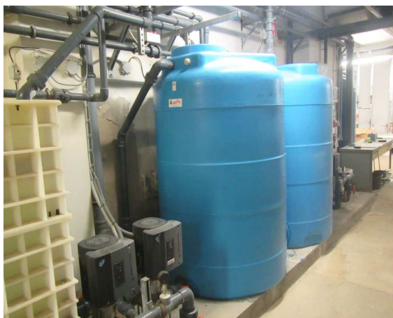
Obr. 17 – sběrná a zásobní nádrž a čerpadla speciálního čištění vody
