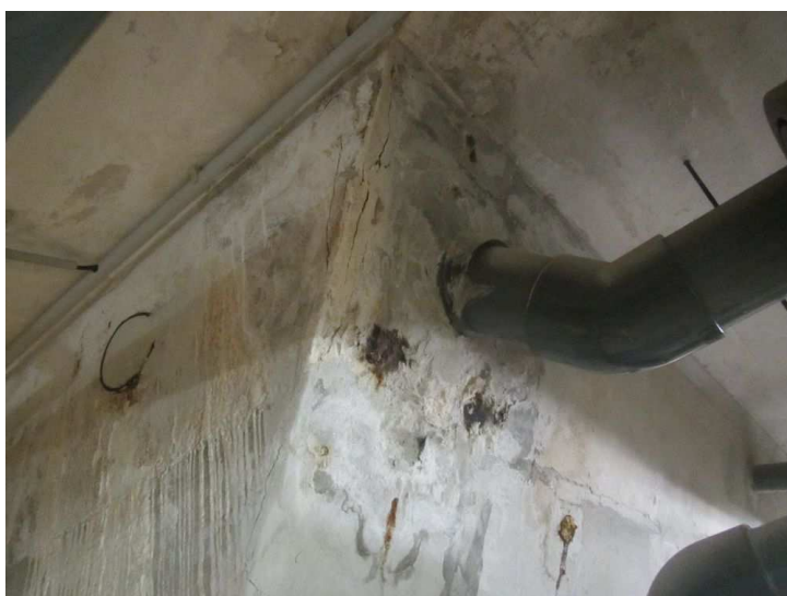
Obr. 2 – poruchy na stavebních konstrukcích v 1.NP – hlavně v místech prostupů technologických rozvodů přes stavební konstrukce s hydroizolací
